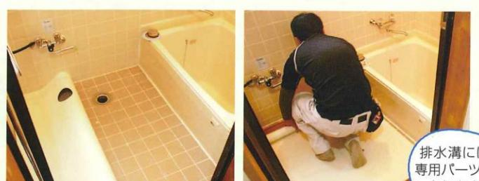
現場で型紙を取り、その場で専用シートをカット。水が入らないよう、コーティングを施し、乾くのを待って完了です。施工後3日で使えます。
