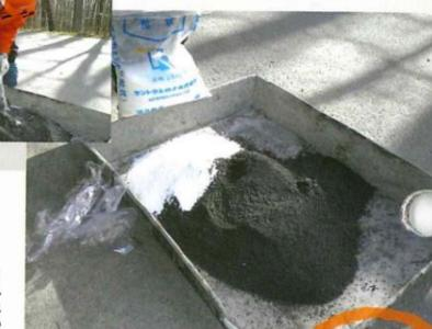
まずは砂作りです。砂の凍結防止に塩化カルシウムを混ぜます。砂9:塩カル1の当管理センターM主任自慢の黄金比率で土嚢袋に詰めて行きます。環境にもやさしい滑り止め砂です。
